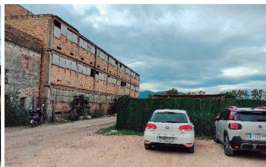
Vista cap al sud des de l'aparcament
